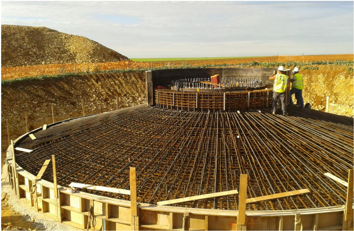
Fondation après ferrailage, avant coulage du béton (réalisation du coffrage)
