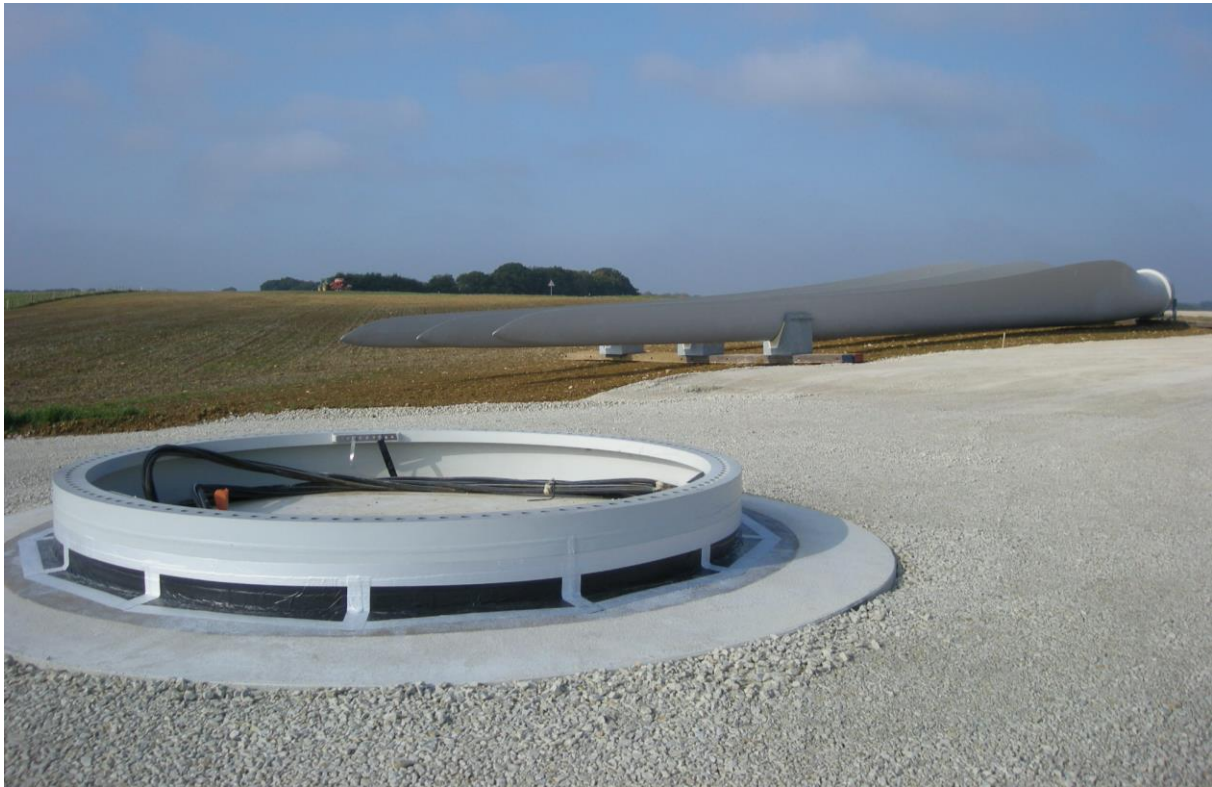
Montage d'une section de mât
