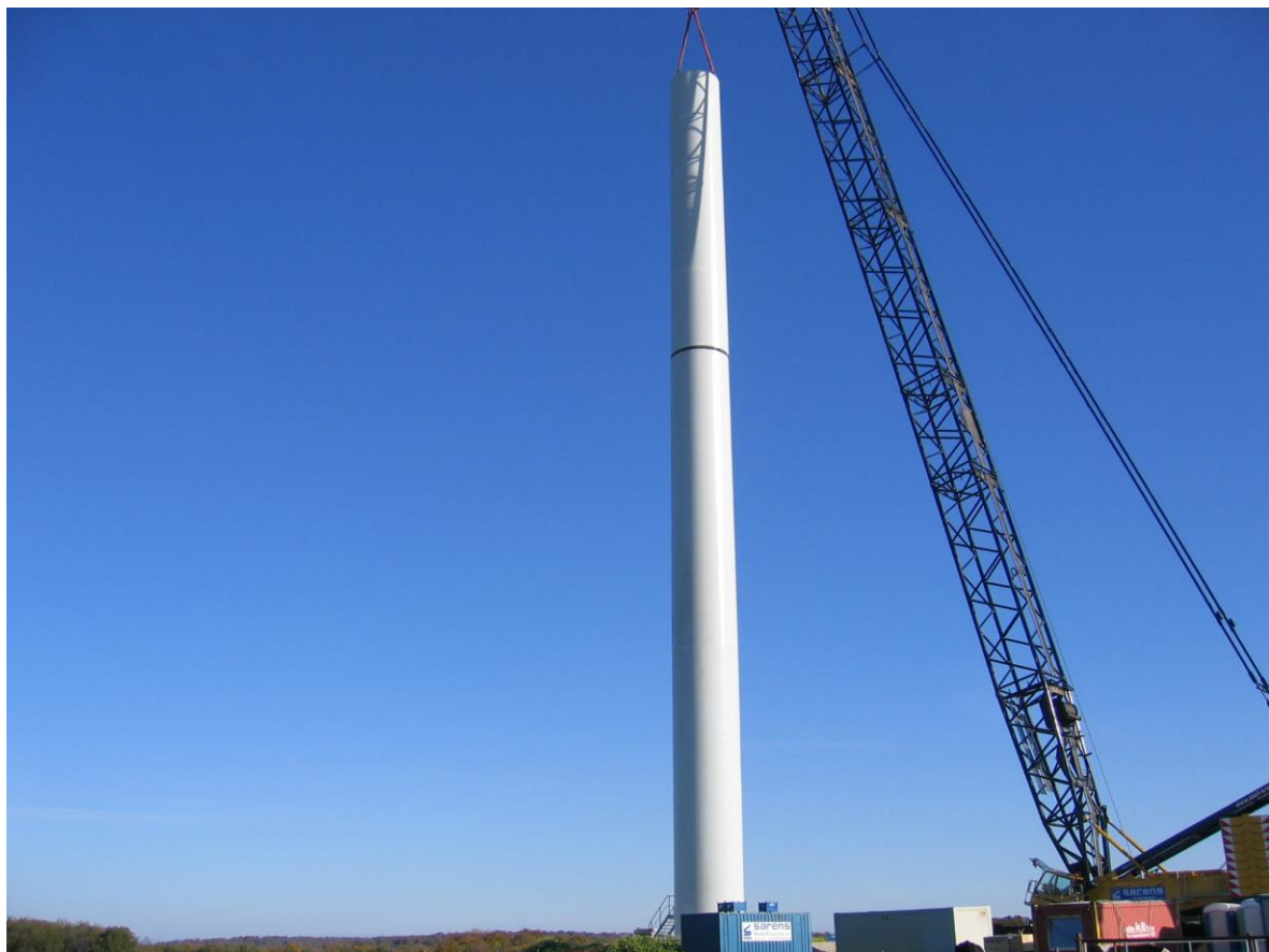
Montage d'une section de mât
