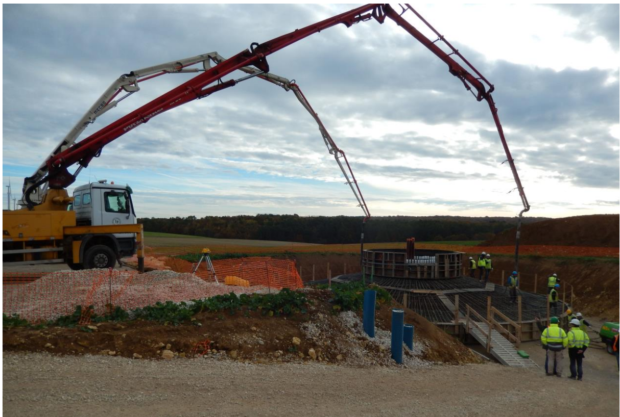
Fondation pendant le coulage du béton
